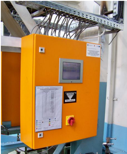
Sterownik – ekran pokazujący schemat pracy poszczególnych podajników
